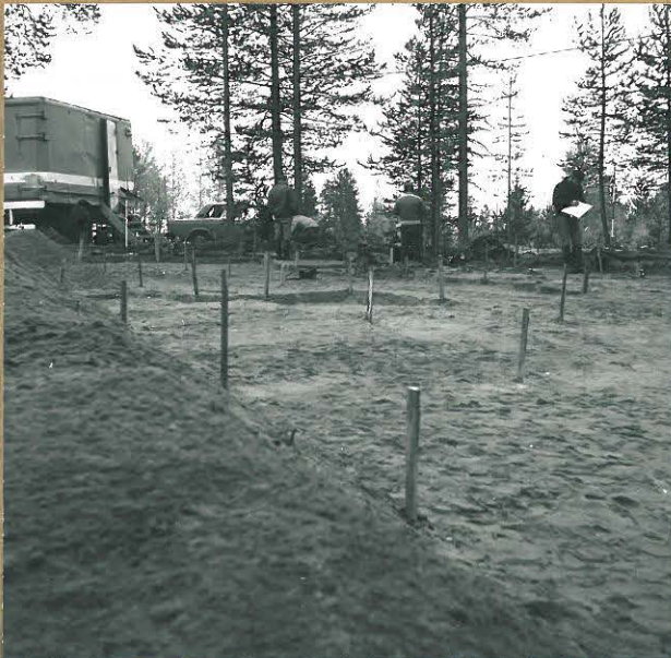
Kuva 25. F. 60824 Kaivausalueella 3. työskennellään. Idästä. (Alueen länsipää).
