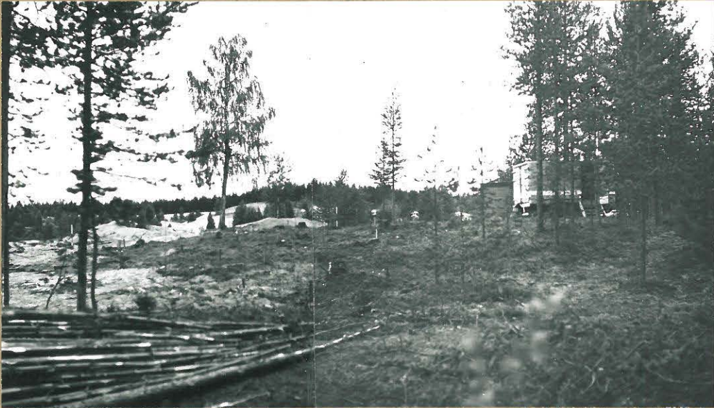
Kuva 24. F. 60816-60817 Yleiskuva kaivausalueesta 3. suunt kaadettuina ja osittain paalutettuna. Peljäs-koillisesta.
