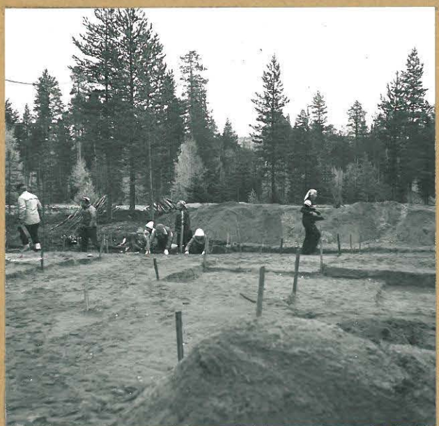
Kuva 27. F. 60826 Kaivausalueella 3. työkennellään. Lännestä (alueen itäpäää).
