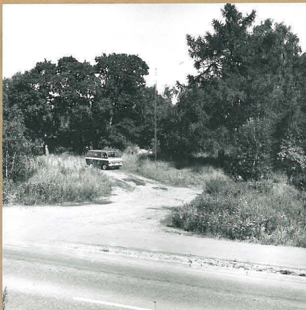
f.68047 Yleiskuva koekaivausalueesta, oikealla entisen dlutpanimon kellari, kuvattu etelästä.
