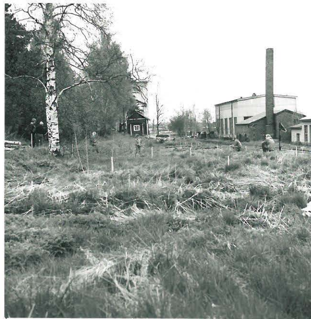
55963 2. Talon "2" alueen al- leutaa paalutettuna. lounaasta koilliseen
