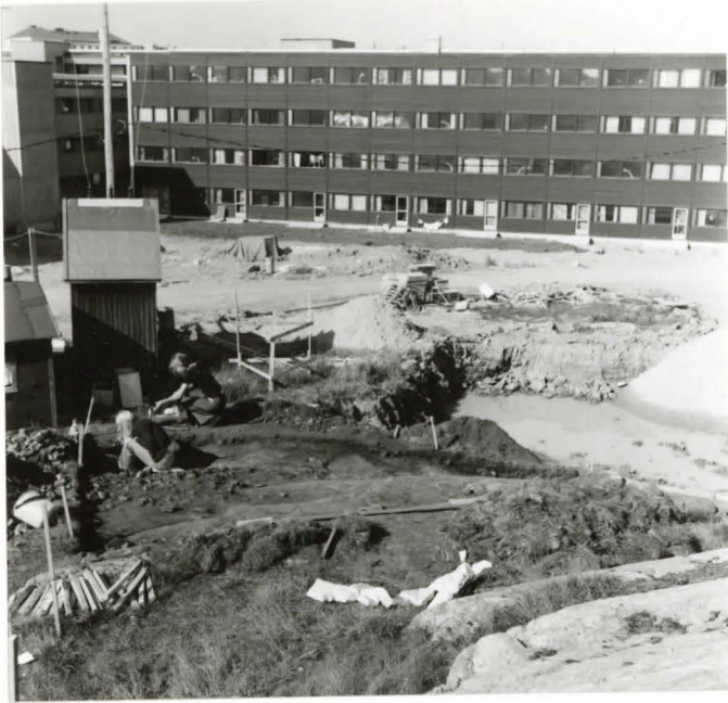
1. Kaivausalue I itäkoillisesta päälinjan A-B suunnassa kaivausten lopussa. (negat. TYA 1285)
