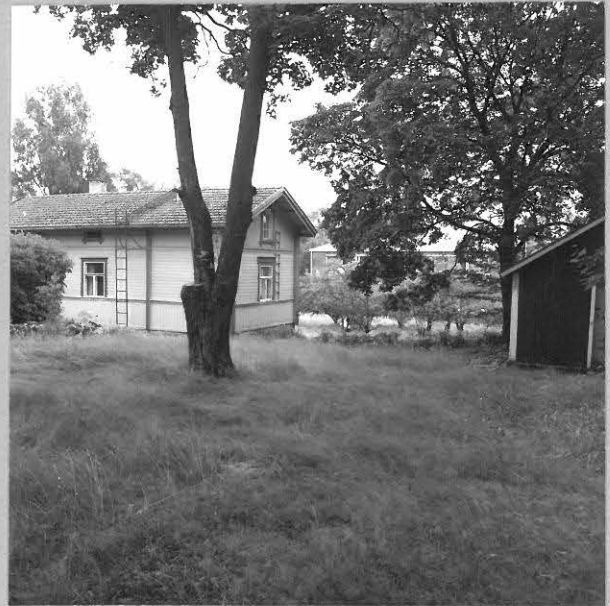
KUVA 4. F. 98281 TONTTU LÄNSIOJAA JA 1800-LUVUN LOPULLA RAKENNETTU PÄÄRAKENNUS, KUVATTU LÖUNASTA.
