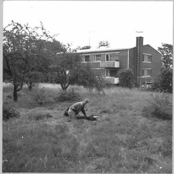
KUVA 2. F. 98279 TONTIN PUUTARHAA JA TONTIN 24 KERROSTALO, KUVATTU LÄNNESTÄ
