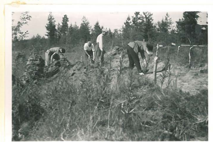
ENSIMMÄISTÄ RIVIÄ KAIVETAAN.
