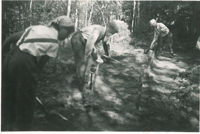
KAIVAUS ALKANUT ALUEELLA ALASUVANTO II
