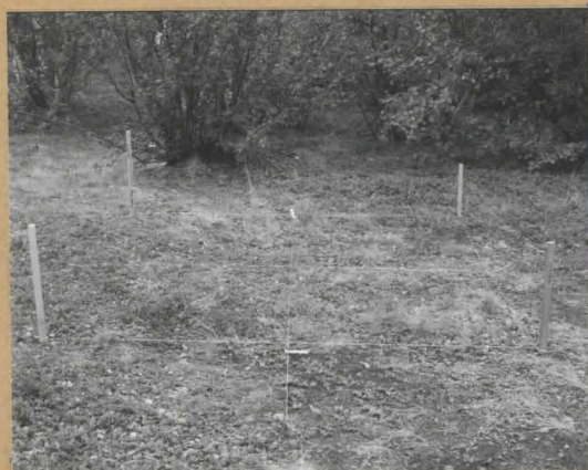
67391 40. Alue 8 ennen turpeenpoistoa, idästä
