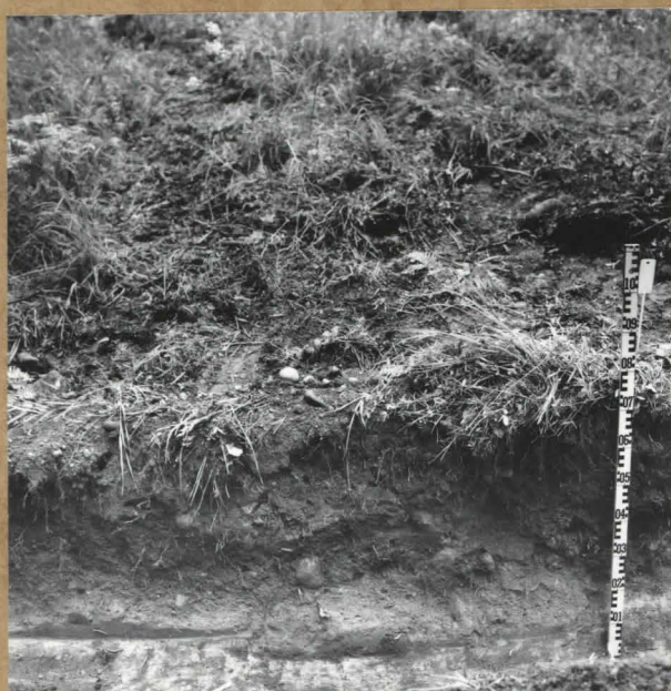
Kuva 3. Neg. 76592. Profiilikaivantoa 4-6 m:n paalujen kohdalla. NE.
