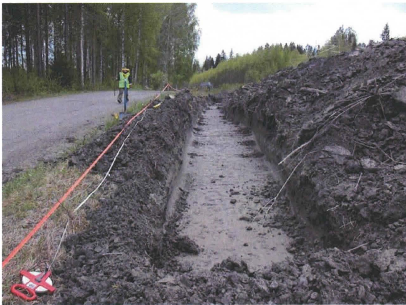
Kuva 2. Näkymä Kaukonientien länsipuolella sijainneesta valvonta-alueesta (Osa-alue 1) ojan kaivamisen jälkeen. Kuvattu koillisesta. Kuvaaja: Kalle Luoto. Raportin digitaalikuva 008.jpg.
