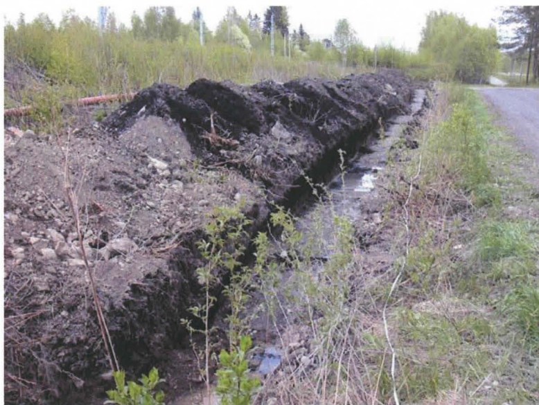
Kuva 5. Valvonta-alueen osa-alue 1 kaivettuna. Kuvaaja: Kalle Luoto. Raportin digitaalikuva 005.jpg.
