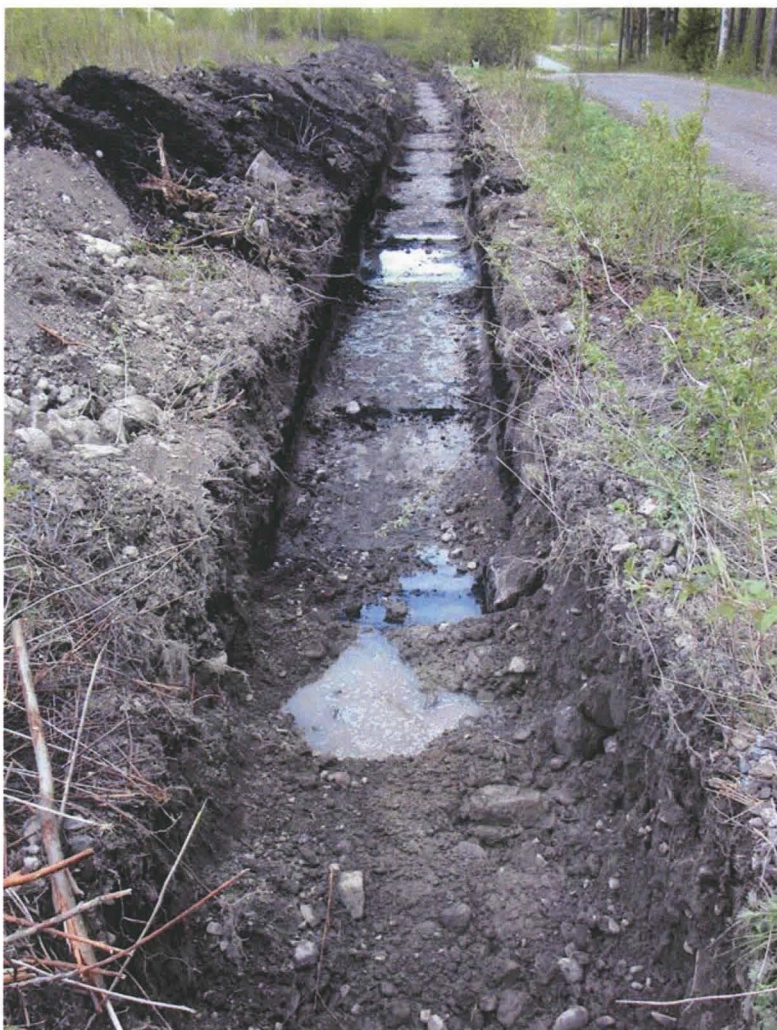
Kuva 6. Lounainen valvonta-alue kaivettuna. Kuvattu etelälounaasta. Kuvaja Kalle Luoto. Raportin digitaalikuva 004.jpg.
