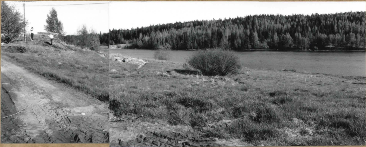
F. 110969-70 TUTKIMUSALUETTA TALON 2 KOHDALLA ENNEN KAIVAUSTA. KUV. LUOTEESTA.
