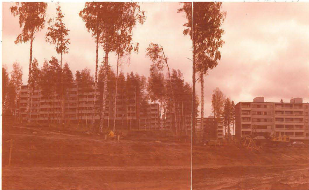
yleiskuva kaivausalueesta. Kuvattu lännestä.
