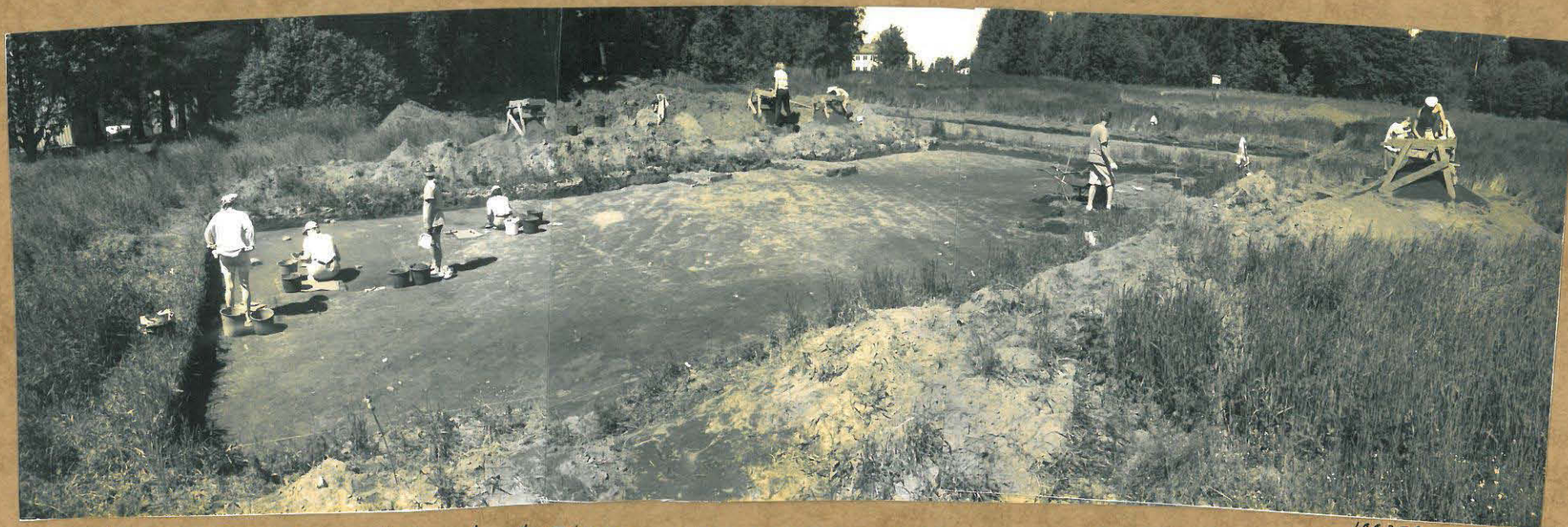
K3. Alue A6, yleis- ja työkäiva, pölvöraama pintamaan pöitosta ja T kerroksen kaivamisesta, kohti WVV
