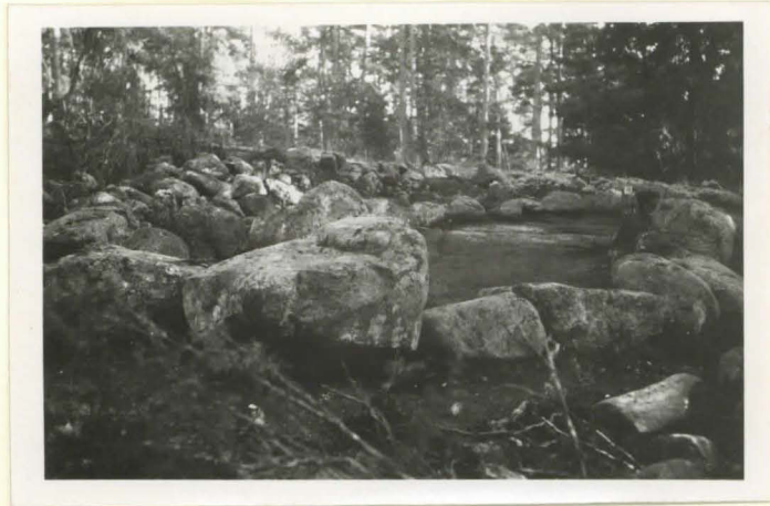
Kuva 14a. Talvapaan latomus esin kaivettuna. Kuvattu laulasta.
