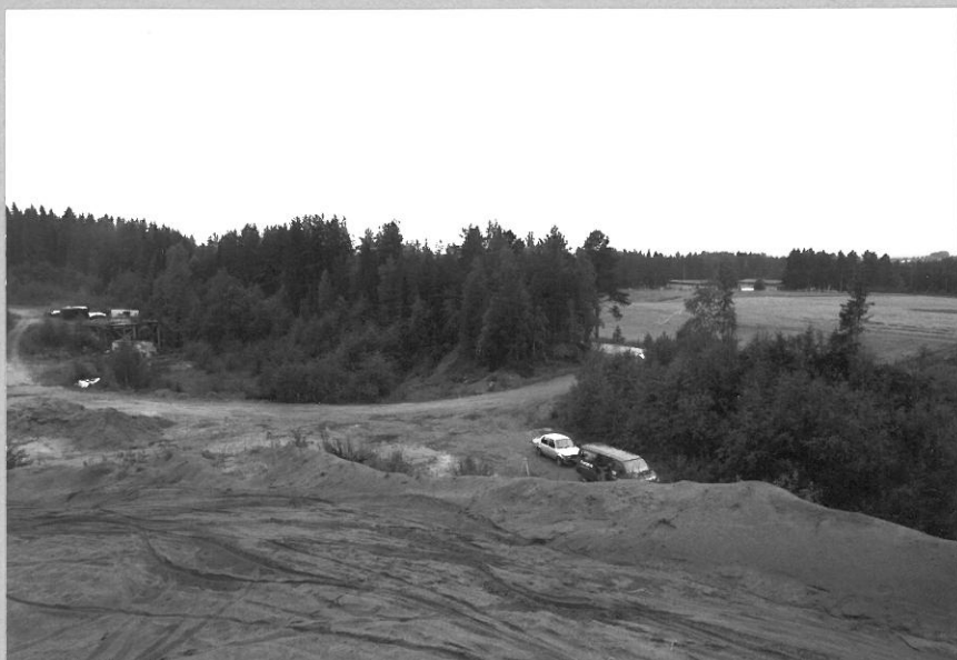
KUVA 3 . F. 95180 YLEISKUVA ETELÄÄN , PELLONREUNASSA VANHA IISALMI- OULU - MAANTIE , KUVATTU PÖHJOISESTÄ .
