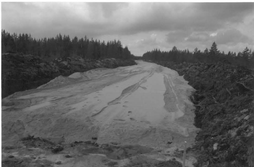
Kuva 83. Tuleva tielinja täytetty soralla, kaivausalueelta 9 katsottuna, E-W. 2.7. (f. 116176)
