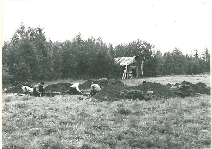
KAIVAUS KÄYNNISSÄ. KUVA LOUNAASTA.
