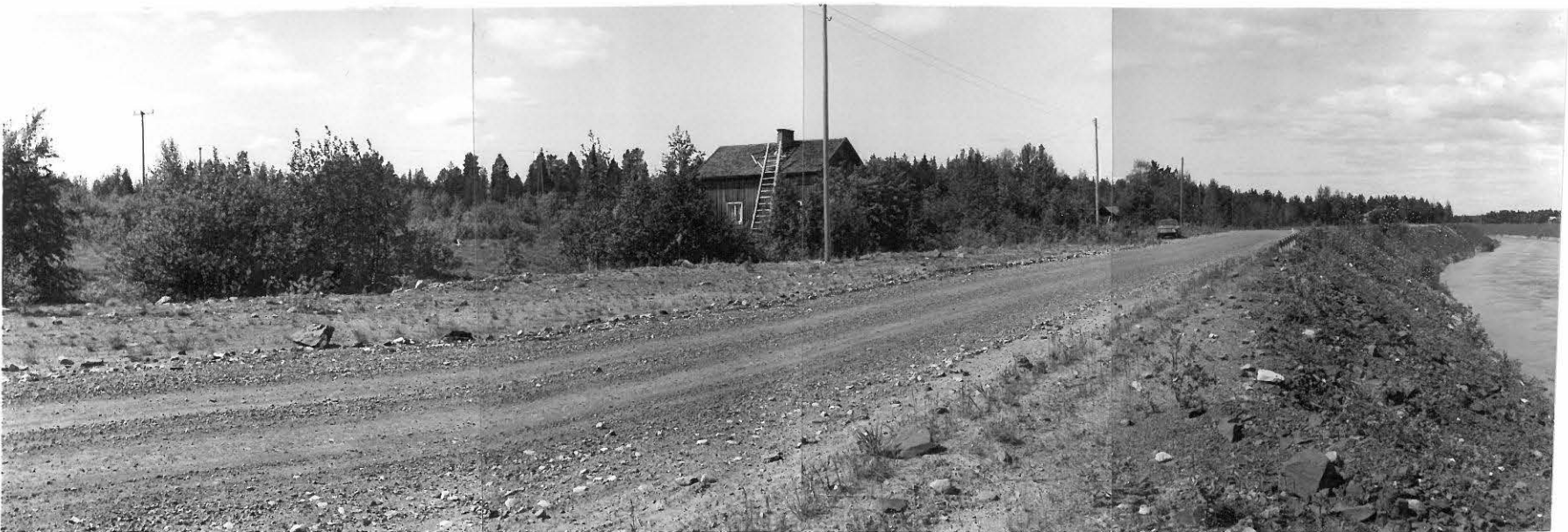
VÄLITALO IDÄSTÄ KUVATTUNA. OIK. KIERIKIN VOIMALAITOKSEN ALAKANAVAA. (KUVAT 1-4).
