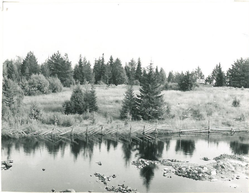
F 25814 Asuinpaikka luoteesta, Pahka- kosken voimalaitoksen alakanaavan ete- läisen vallin päältä, kuvattuna. Asp. pellon korkeimmalla kohdalla keskellä olevien kumien takana.
