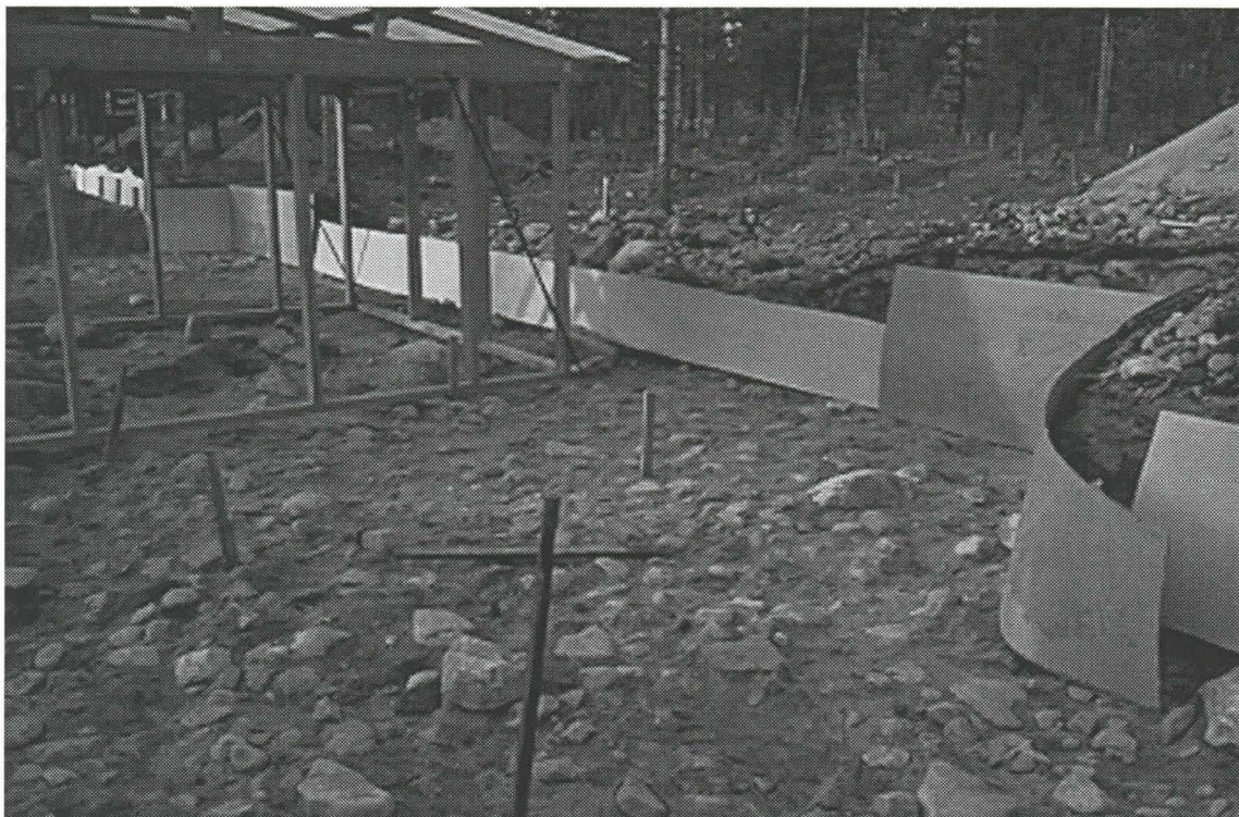
Kuva 45. "Tien" luontaista pohjakiveystä kodanpohja 2:n tienoilla, katos suojaa "hautaa". Kaivetun alueen reunat peitettiin kovalevyillä ennen täyttöä. Kuvattu luoteesta 30.9.1994. Dia n:o 20016.
