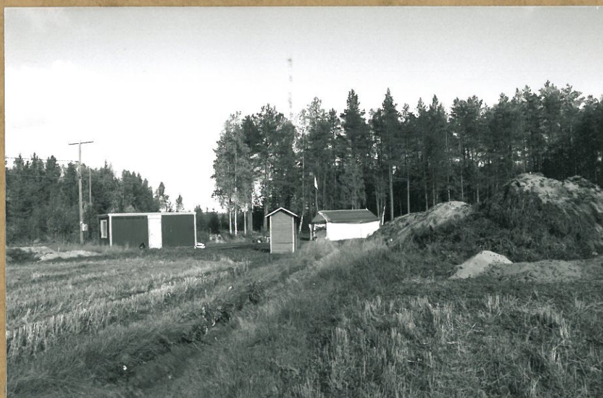
110431 Kuva 2. Yleiskuva Leualanpellon pohjoispäästä, missä työtilat sijaitsivat. Kaakosta.
