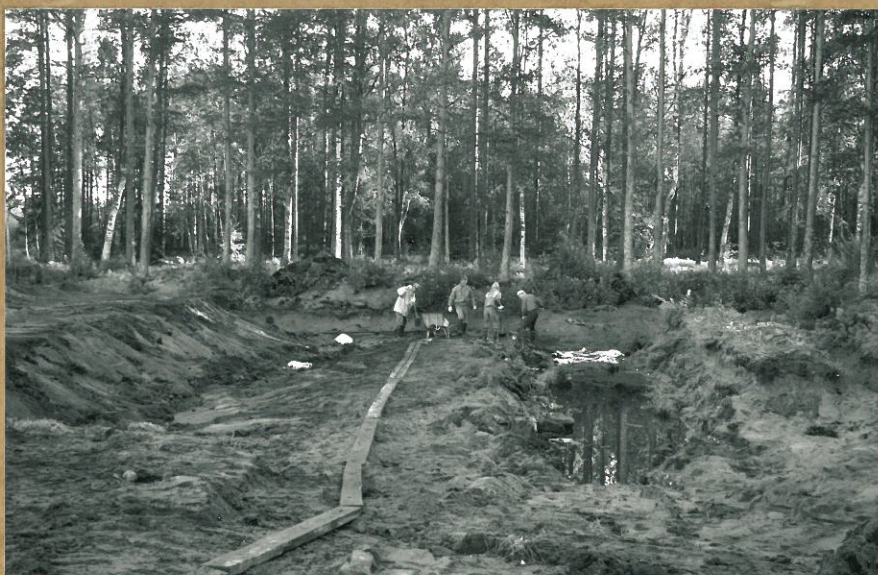
110316. kuva 6. Kaivausalue 1-2, alueita puhdistetaan kaivinko- neen jälk. Etelälounaasta.
