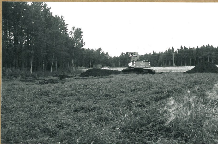
110375 Kuva 70. Kaivausalue 7. kaivinkone poistamassa turve- ja tulvahiukkakerroksia. Idästä.
