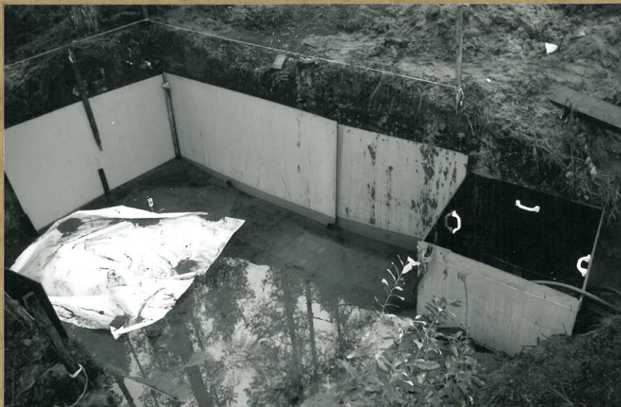
110384 Kuva 62. Kaivausalue 6; seinämät eristetty venivane- rilla, oikealla pumppukäyttö. Kuvaushetkellä pohjavettä n. 20 cm kaivauksen yläpuolella. Idästä.
