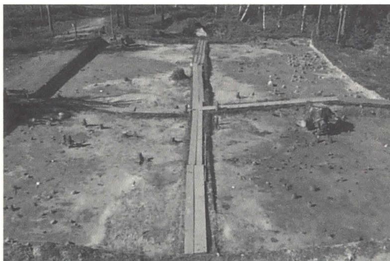
Kuva 8. Asumuspainanne 63, länsiosa; (f. 118076) taso 5, kuvattu idästä.
