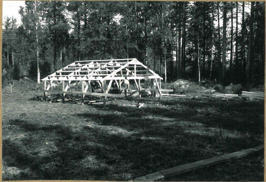
Levalampelto sääsoja rakennetaan.
