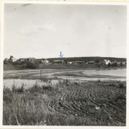
K. 31. Nahkiala, Torkkonmäki, Äykelö. Äykelön talon pihaan tönkötetty heij- känkärki. Valok. lounaesta.
