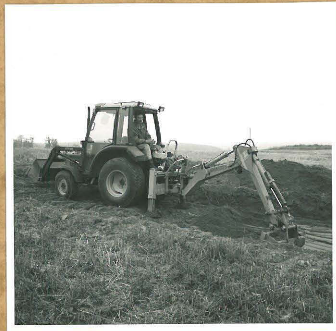
Kuva 4. Peltomultaa poistetaan Kubota f.88388 L2550-kaivinkoneella.
