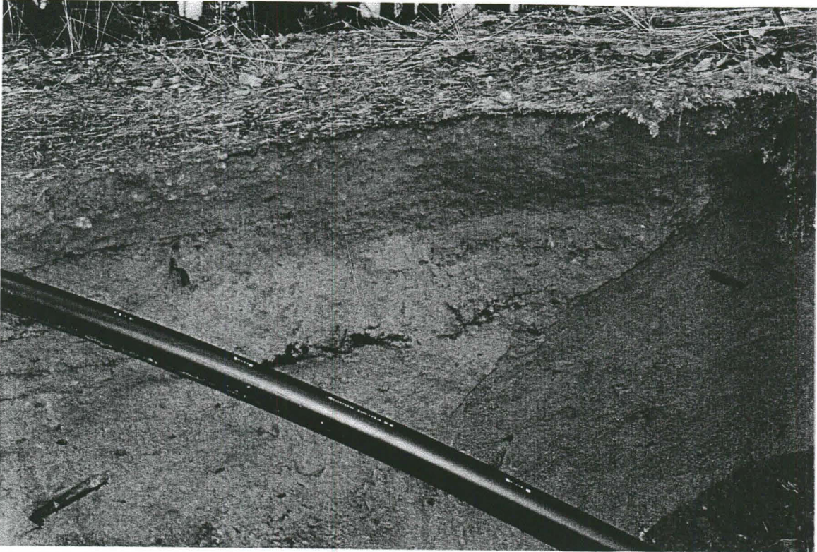
Kuva 2. Tiekerros ja jv-viemäriputki
