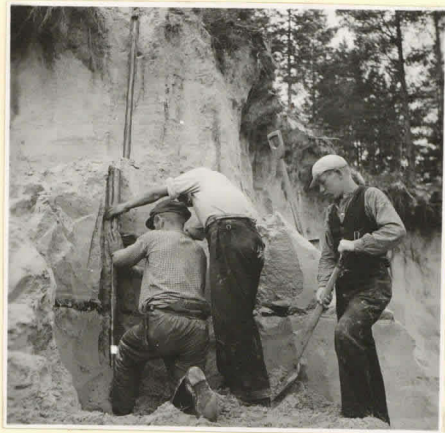
12. Maanäytteen ottaminen ranta- leikkauksilla.
