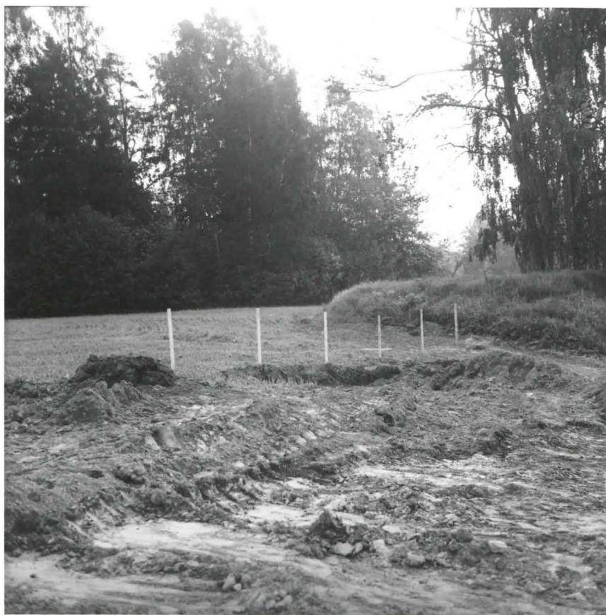
59737 Kuva 4 Yleiskuva kaivausalueelta. Pintamulta poistettu tutkittavalta alueelta koneel- lisesti.
