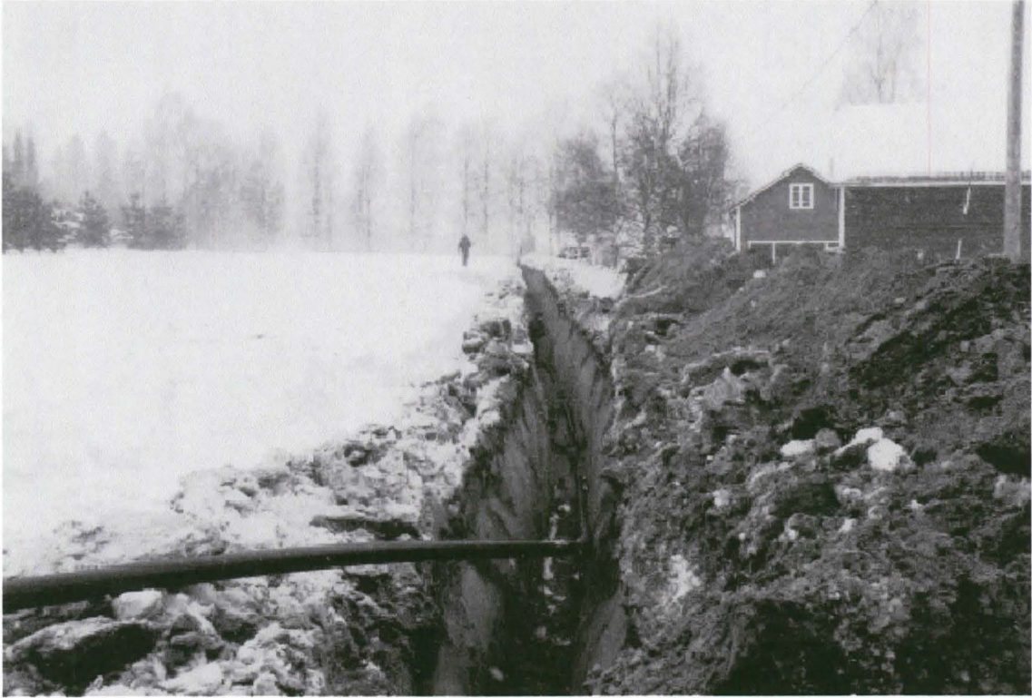
115928 Vesiputkikaivanto loppuun kaivettuna. S 13.3.
