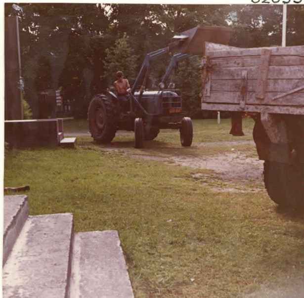
35. Jrtomaan siirtoa varten saatiin lainata Yli-Nuoranteen etukuormaajaa sekä perävaunua, mikä helpotti huomattavasti kaivamista. "Koneenkäyttäjänä" toimi Rauno Hilander.
