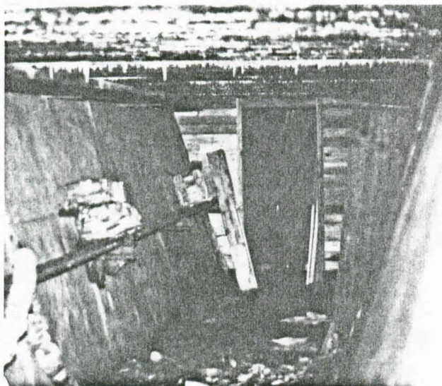
KUVA 21. Miehistösuojasta (Mie 2) johtava käytävä, joka levenee ylöspäin. (S 7288)
