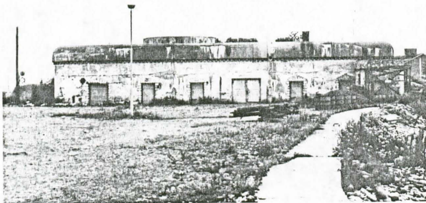
KUVA 29. Koneasema. Aseman katon yläpuolella näkyy valonheittimen valaisuasema ja sen oikealla puolella on ilmatorjunta-asema. (S 7660)
