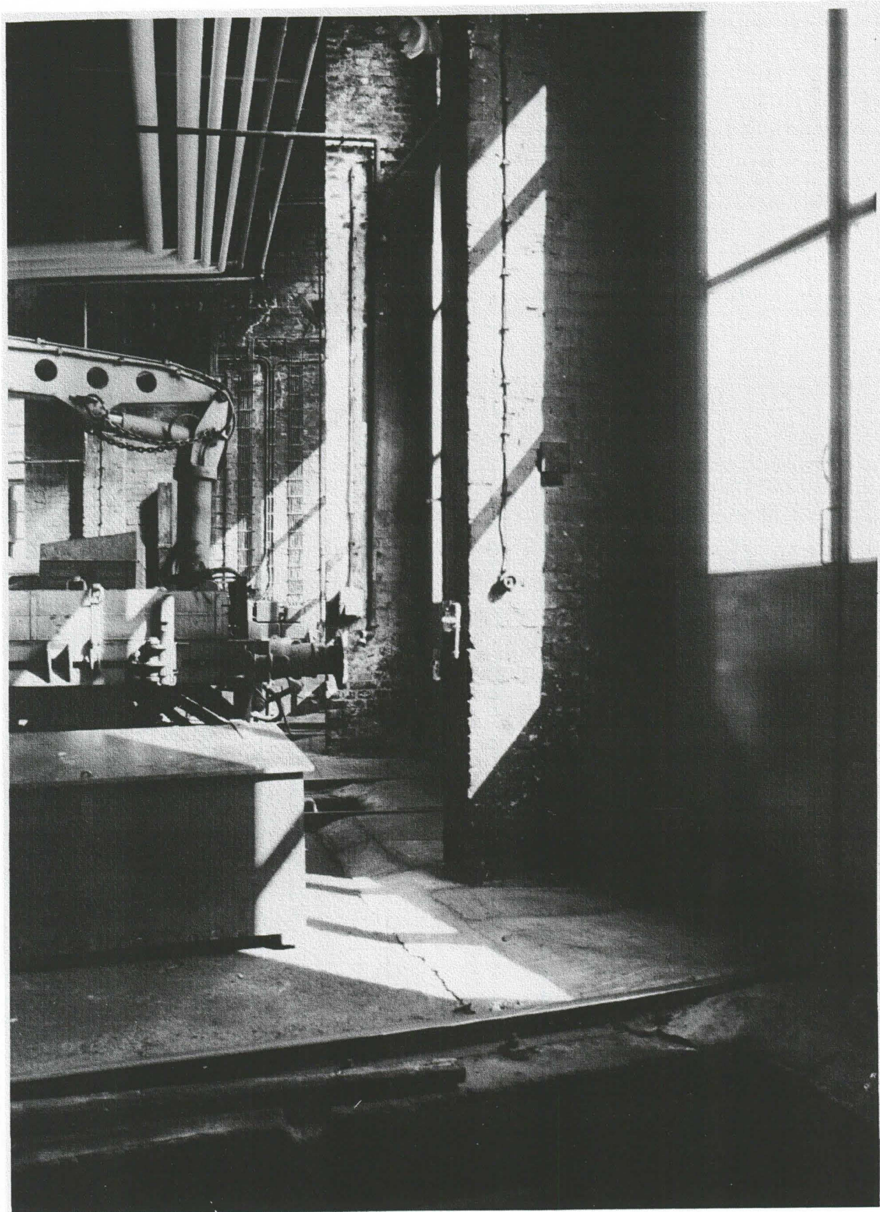
Pohjoinen veturitalli. Sisätily. Kuva Pia Pärepaio.
