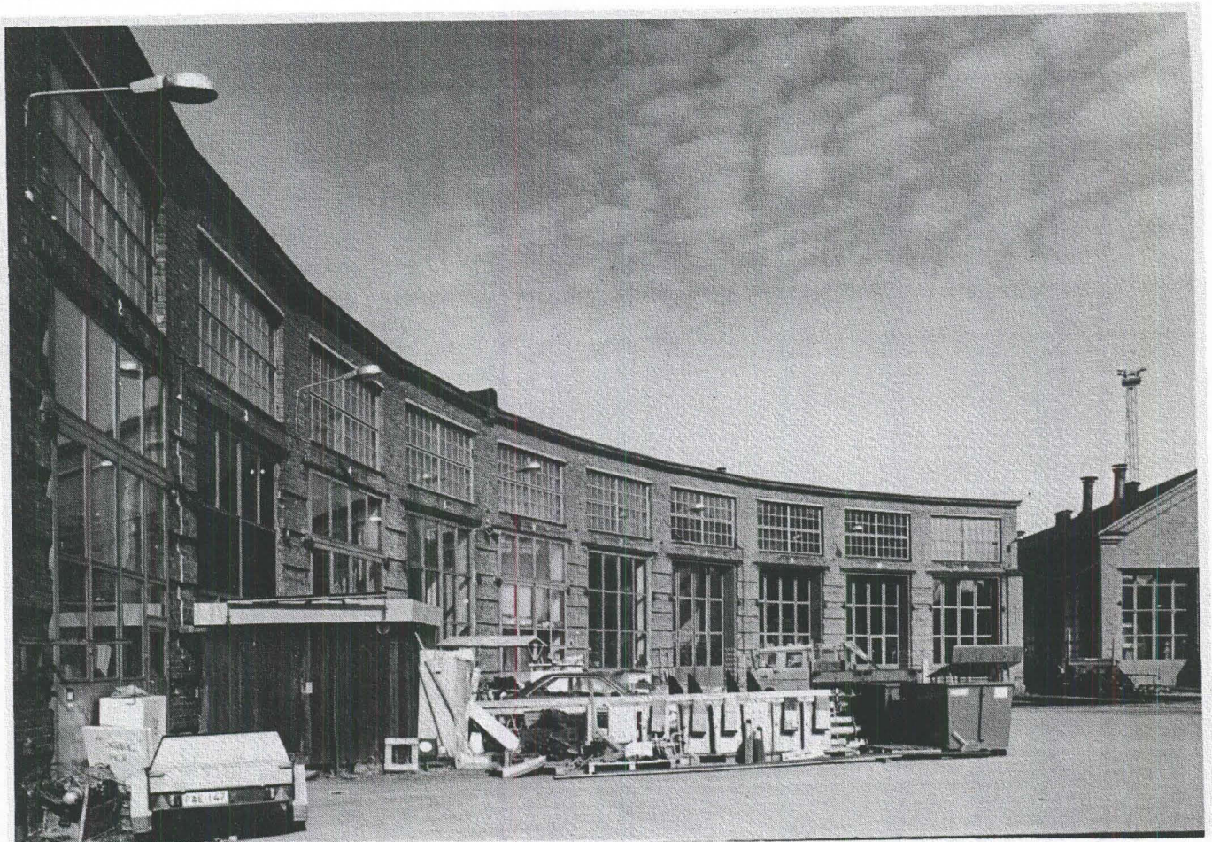
Kaarijulkisivuja. Pohjoinen veturitalli.
