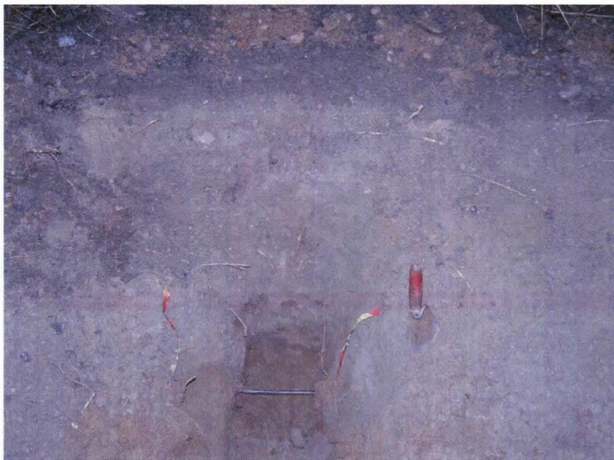
Kuva 7. Valopylvään paikka. Reilun puolenmetrin syvyydessä meni sähköjohto. Kuvattu SE-suunnasta.
