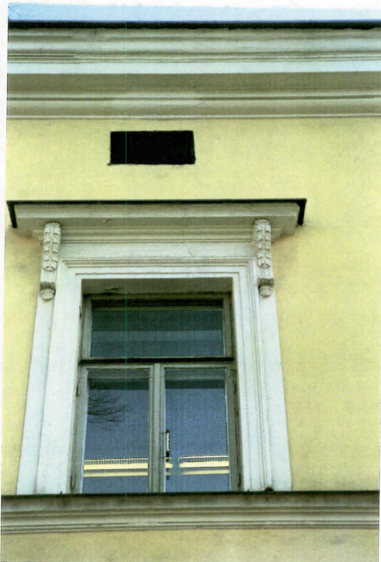
AIEMMAN SYNNYTYSLAITOKSEN IKKUNAN T-PUITE. IKKUNANKEHYS RAKENNUKSEN ENSIMMÄISESTÄ RAKENNUSVAIHEESTA
