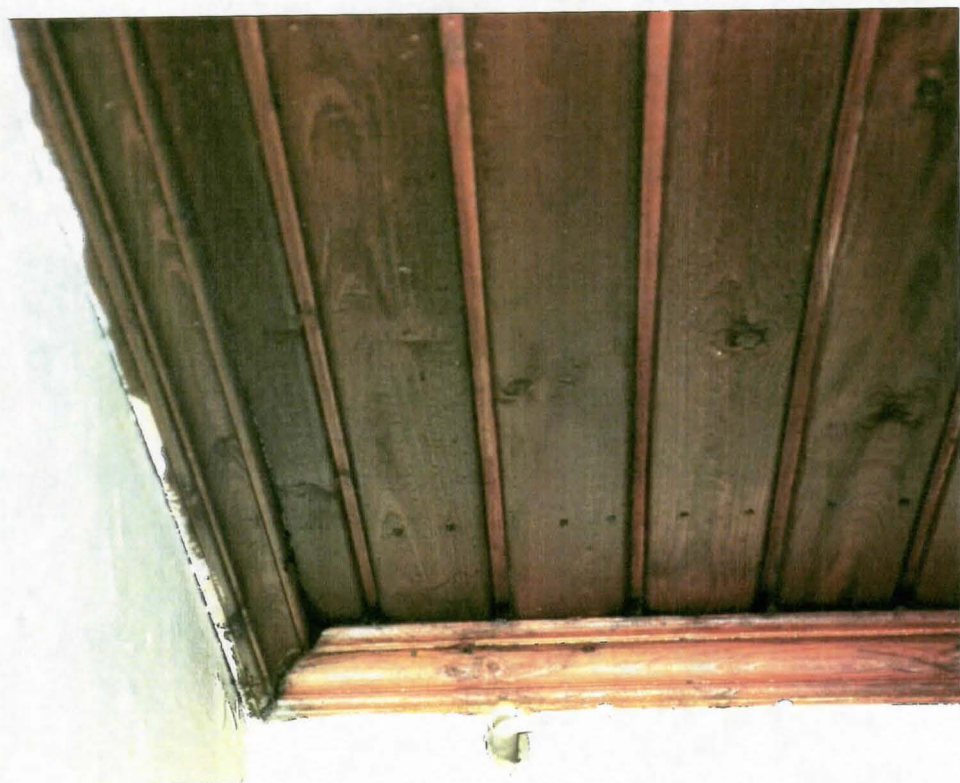
AIEMMAN PESULARAKENNUKSEN TOISEN KERROKSEN AULAN LAUTAKATTO JA KATTOLISTA
