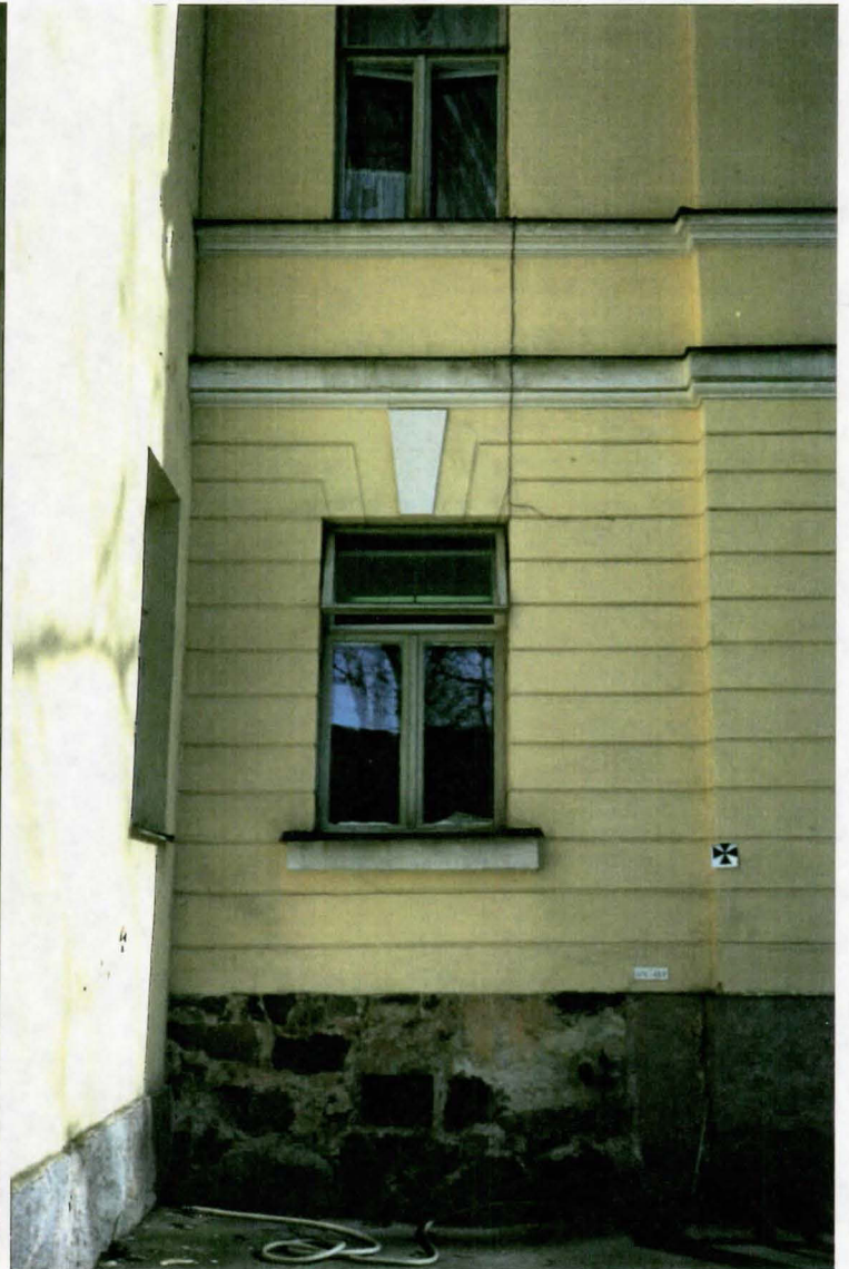
AIEMPI SYNNYTYSLAITOS. IKKUNAN YLIN RUUTU, NS. TERVEYSIKKUNA AVATTU
