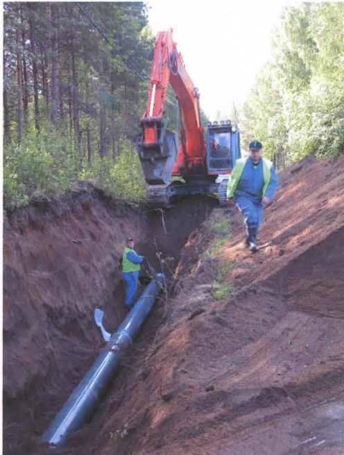
Putkikaivantoa oli kerralla auki vain noin 10 metrin matkalta
