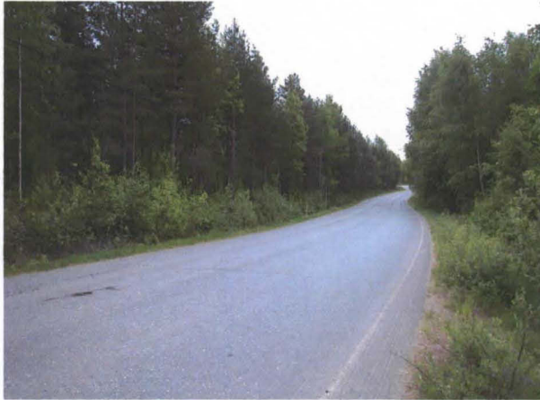
Valvottava alue vasemmalla ennen putkikaivantoa luoteesta
