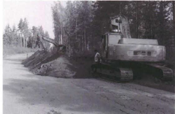
131448. Putkilinjaa kaivetaan. SW.
