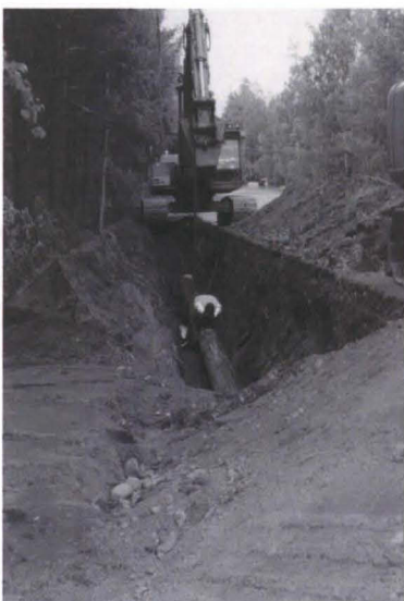
131449. Putkilinjaa kaivettiin tien välittömään yhteyteen. NE.
