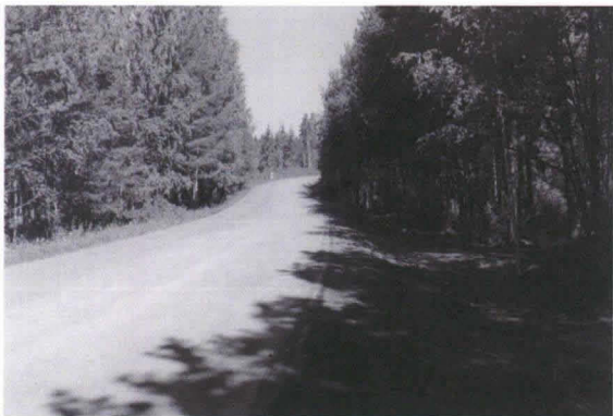
131451. Valmis putkilinja kuvan keskellä. S.
