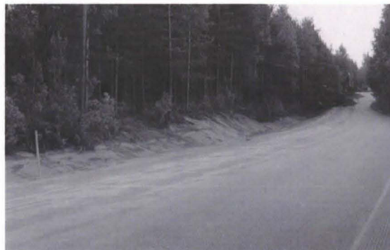
131450. Valmis putkilinja kuvassa vasemmalla. NW.
