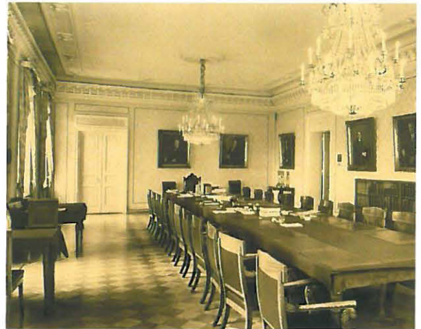
Plenum ennen muutosta.
