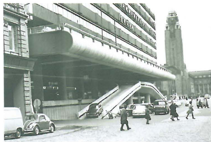
Uudenmalliset liikennevalot ohjasivat Keskuskadun ja Kaivokadun risteyskseen liikennettä "Makkaratalon" kulmassa. Taustalla uudenmallinen valaisinpylväs. HKM 1972
