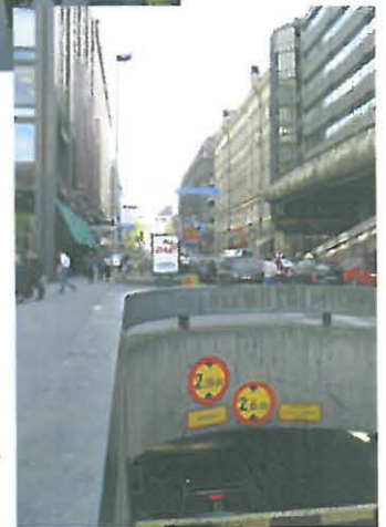
Keskuskadun pintaa lävistävät useat luiskat ja porrasaukot. FU 2003
