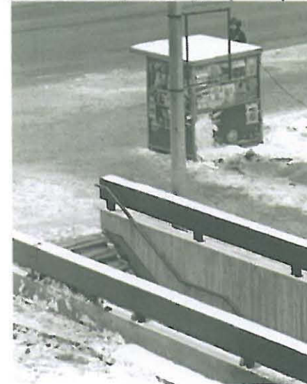
Asematunnelin maanpäälliset elementit, porrasaukkojen tukevat betonikaiteet rikkoivat katualueen perustason. HKM1971
