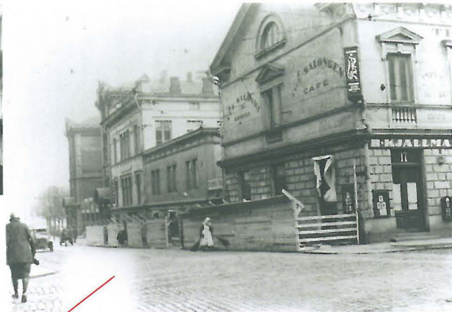
1800-luvulta säilynyt rakennusrivi odottaa purkamista Liittopankin uudisrakennuksen tieltä. Automyynti, miesten asusteliike ja teesalonki ovat väistymässä. HKM 1927
