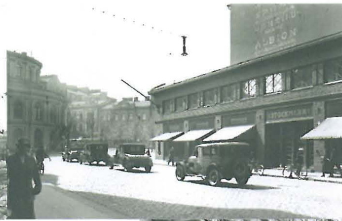
Stockmannin liikerakennuksen eteen pysäköityjä autoja. HKM 1930.
