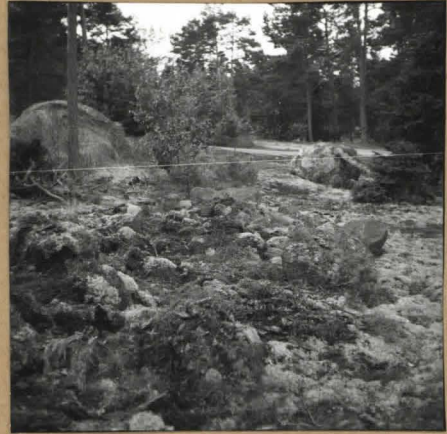
F 53768 Röykkiö 13, ennen paalutusta, kallisesta
