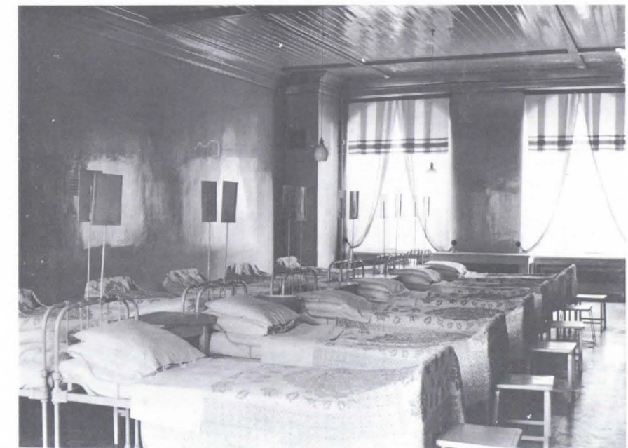
Toisen kerroksen 12 hengen potilashuone, jonka nurkassa näkyy ilmanvaihtohormi riiläaukkoineen. Kuva n. 1900, Sotamuseo.
