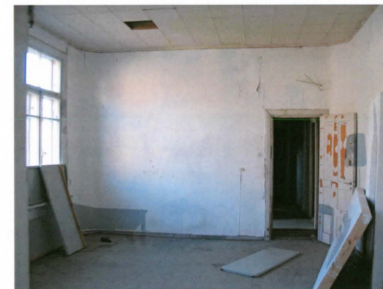
Eristysrakennuksen rapatut hirsiseinät pyörästettyine sisänurkkineen. MSKS 2007
