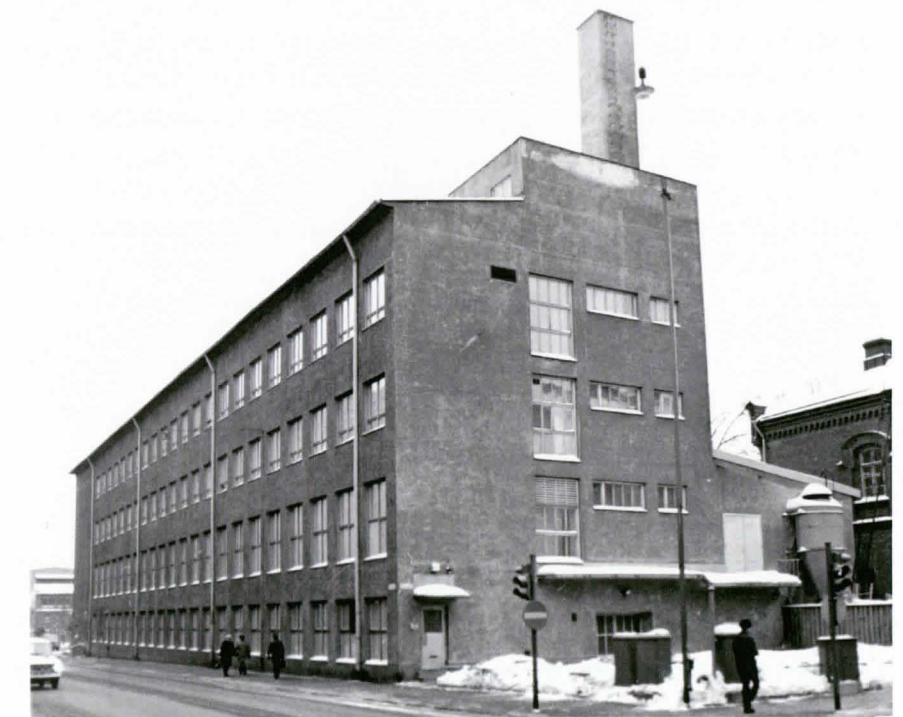
Pohjoispääty Kalevankadulle. VTT
