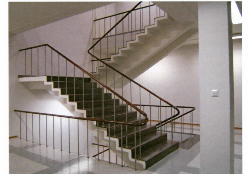
Pääporras, johon alun perin liittyi väljiä aulatiloja
