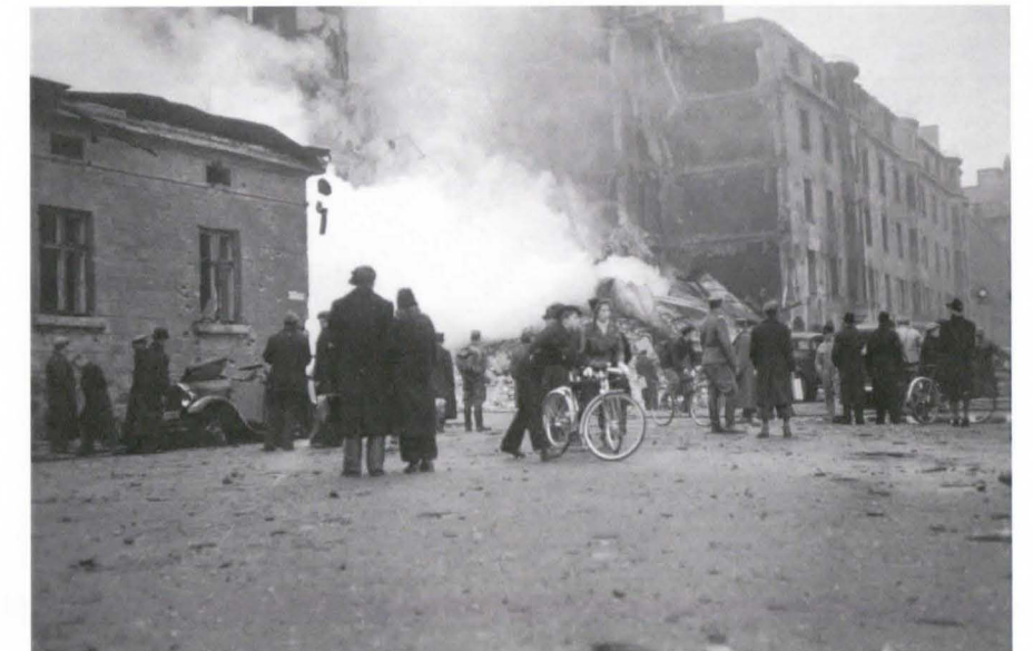
Lasaretin siipirakennus vaurioitui talvisodan ensimmäisessä pommituksessa ja purettiin. HKM
