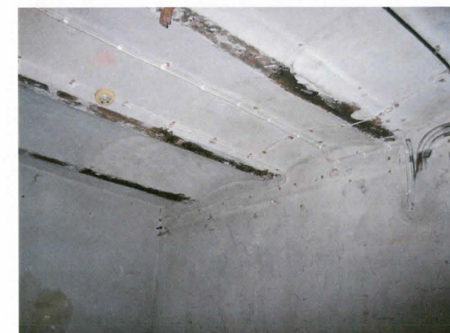
Kellarivälipohjan alkuperäiset kappaholvit
