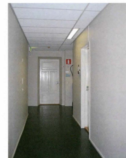
Uusi toimistokäytävä alaslaskettuine kattoineen
