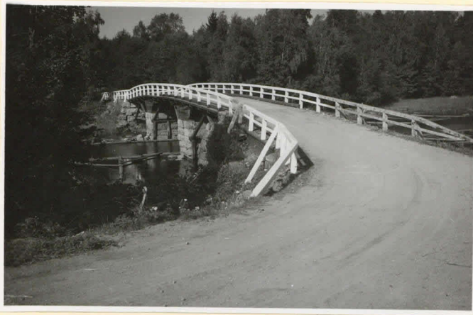
18. Sama silta, kirkonkylän puolelta.
