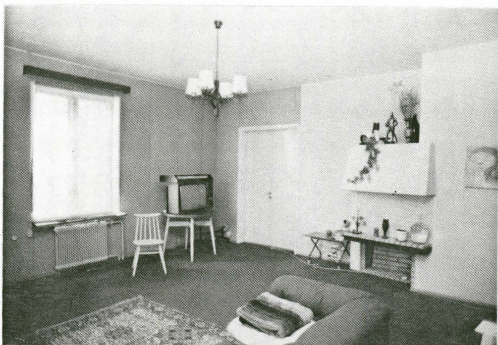
KUVA 22 Alakerran asunnon olohuone (H 101). Katon insuliittilaatat, seinien juuttitapetilla verhoillut insuliittilaatat ja lattian lastulevyn päälle liimattu neulehuopamatto sekä umpeen muurattu avotakka ja keskuslämmityspatterit ovat näkyvää osaa 1950-luvun remontista.
