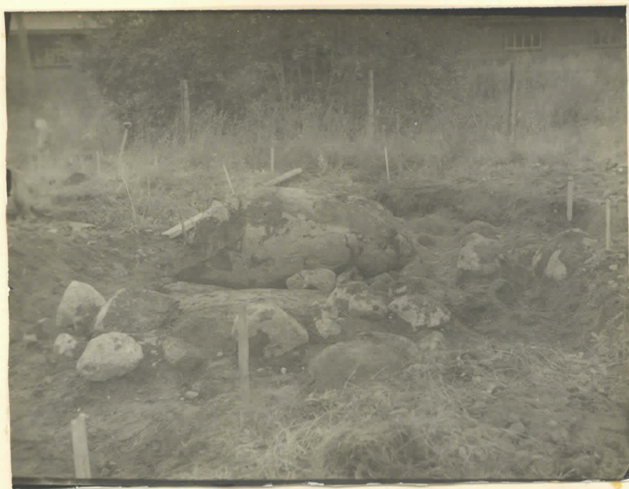
Hättilän röykkiö, pohjalivet paljastettuna. Keskellä korkeat silmäkivet ja sen edessä matala maahivi, ympärillä isoja intokiviä. Silmäkivien vasemmalla puolella kulkun salvojen savenpöly. Takana näkyvä parakki 20. Kuva otettu itäkoillisesta.
