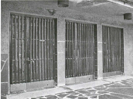
Pääsisääntäntä ulko-ovet ulkoa.
