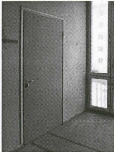
Ovi tyyppi 2, (2. kerroksen käytävä 201.)
