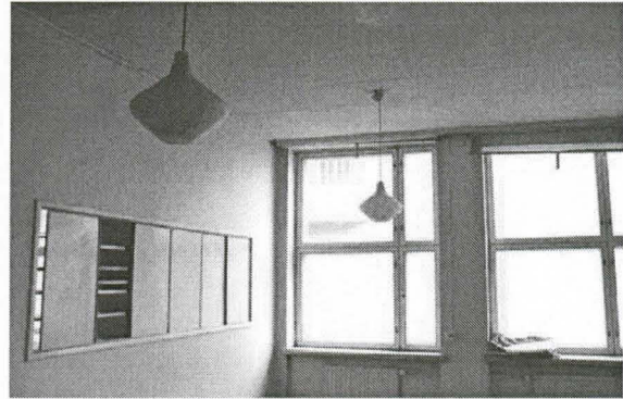
Ikkuna, TYYPPI 1, sisäpuolelta.
