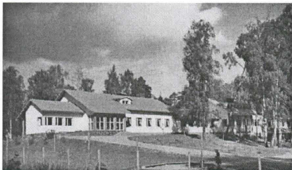
Lindroosien suunnittelemissa Arabian tehtaiden lastentalossa (1943–44) on etenkin 1950-luvun alun arkkitehtuurille tyypillinen laakea tiilillä katettu harjakatto, roiskerappaus ja liuskekivisokkelit, samoin kuin muun muassa Kotitalousopettajaopistossa, Härmälän ja Launeen seurakuntataloissa sekä Lindroosien omassa talossa Helsingin Munkkiniemessä. Kuva kirjasta Suomen teollisuuden arkkitehtuuria (1952) / Foto Roos.
