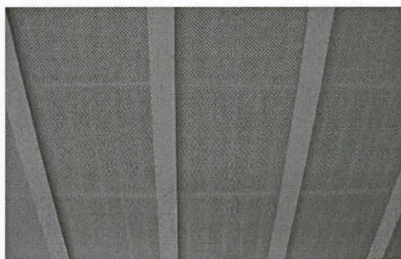
Ruokailutilassa 113 on Soundex-alakattolevyjä saumakohtien päälle myöhemmin kiinnitetty kapeat, valkeiksi maalatut rimat.
