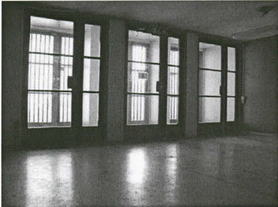
Pääsisääntäntä ulko-ovet sisältä (aula 103, 1. krs).
