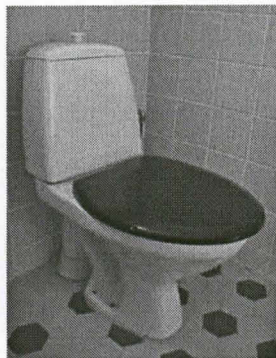
Uusi wc-istuin (kh K44, kellar).)
