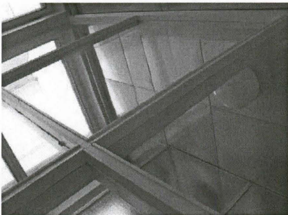
Opetuskeittiön lasiseinä, sisäpuoli (222a, 2. krs).
