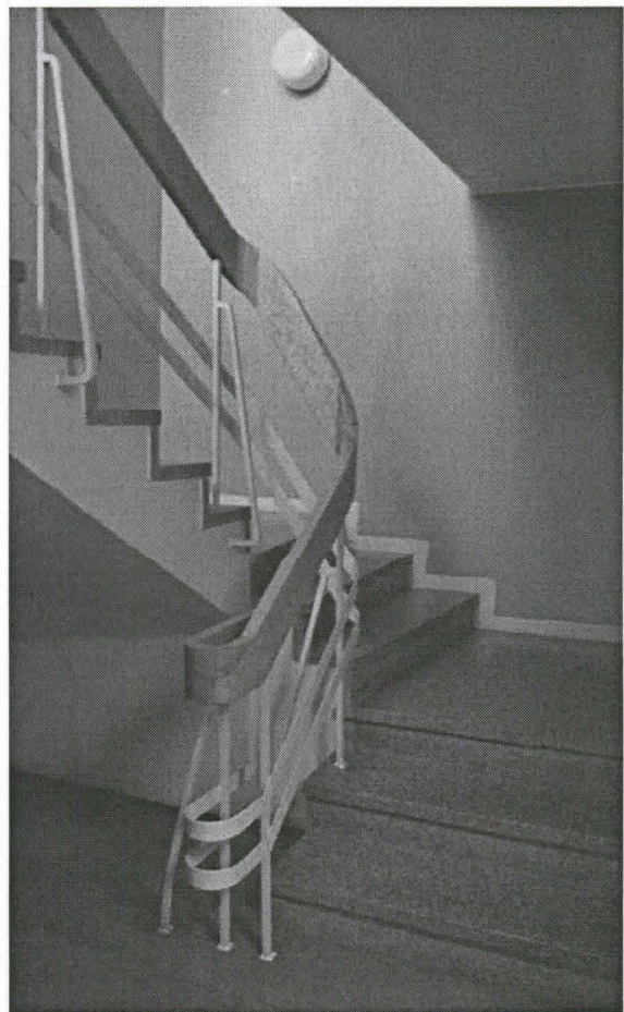
Kellarikerroksen entisen myymälä-kahvibaarin K41 porras sinisine taustaseineineen.
