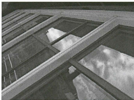
Oppilasruokalan lasiseinä, ikkuna TYYPI 3, ulkopuolelta.
