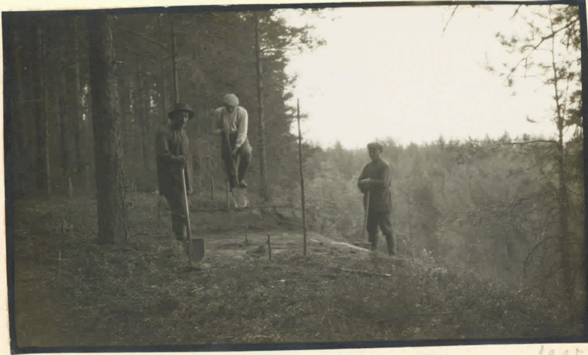
1. Kaivaus Kanavankankaalla. lev 8710
