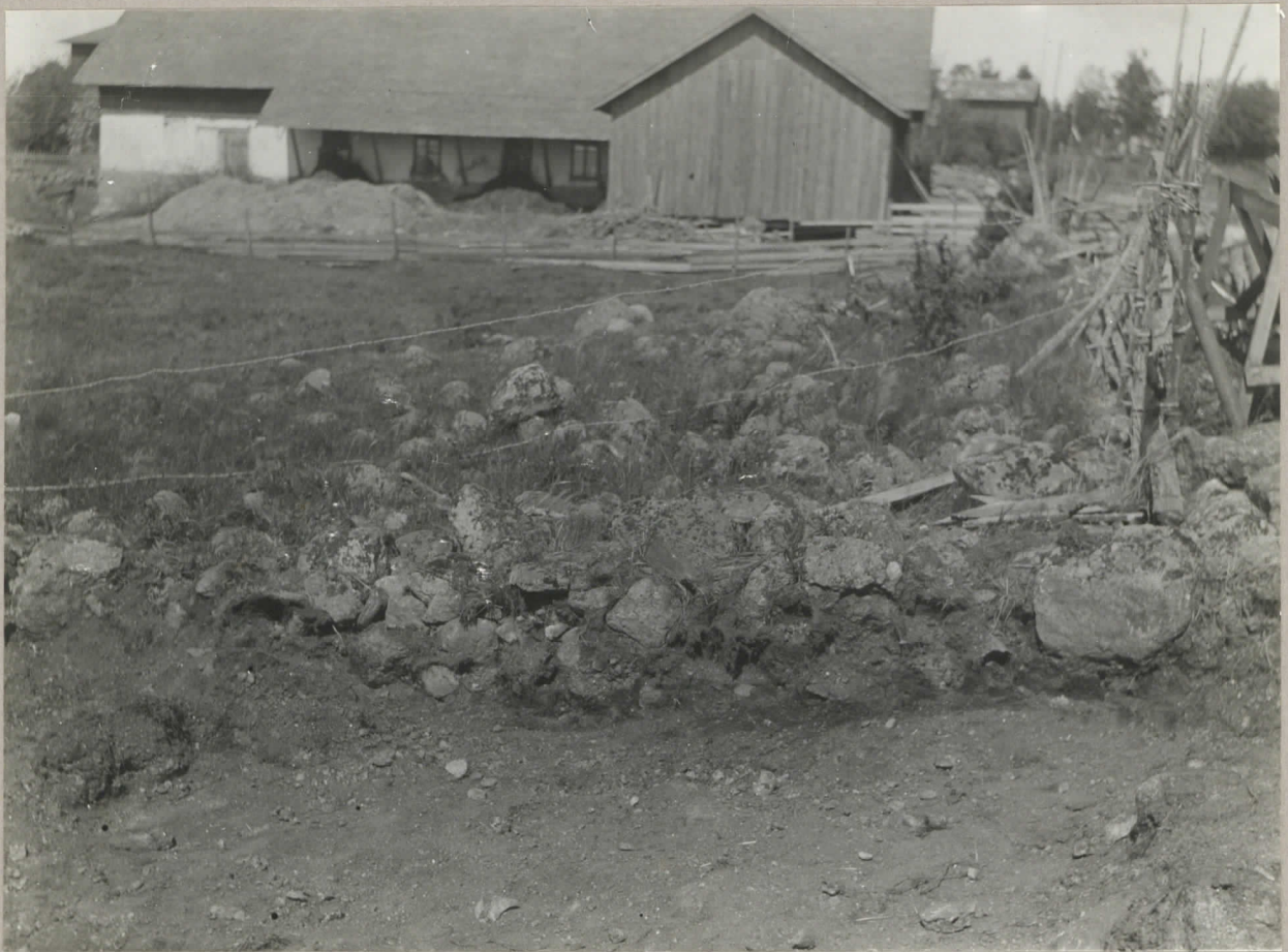
6. Skärningen mot m 6-m9 vid grävningarnas avslutande. 8090.
