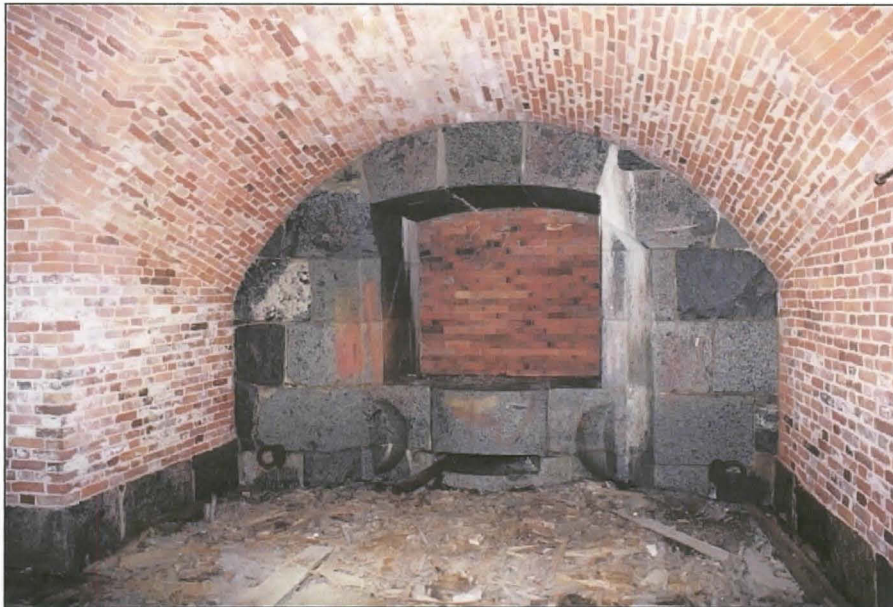
Kuva 8 Patterin 7 tykkikasematin graniittiseinän ampuma-aukot ovat edelleen näkyvissä. Kuva: John Lagerstedt 2002.
