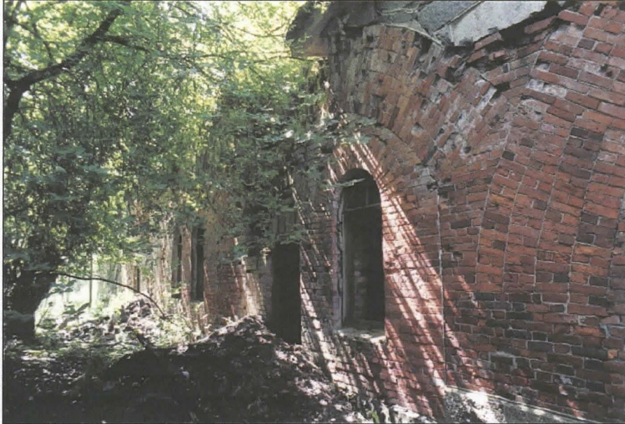
Kuva 11 Patterin 7:n eteen on kerääntynyt röykkiöittäin julkisivusta romahtaneita tiiliä ja kiviä. Kuva: John Lagerstedt 2002.
