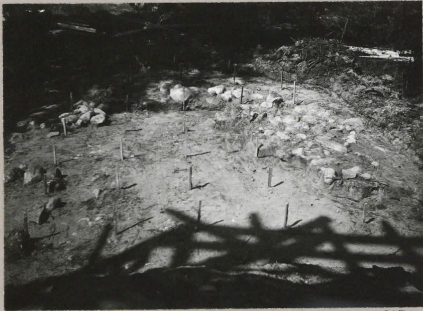
Stens. I 8159. Den orubgade delen av stensplå- nen blottad. Bilden tagen från bygg- nads ställningarna.
