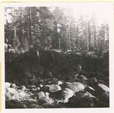
Foto 14200. Södra delens bottenvarv frilagt; norra delen orörd. Bilden tagen från S.
