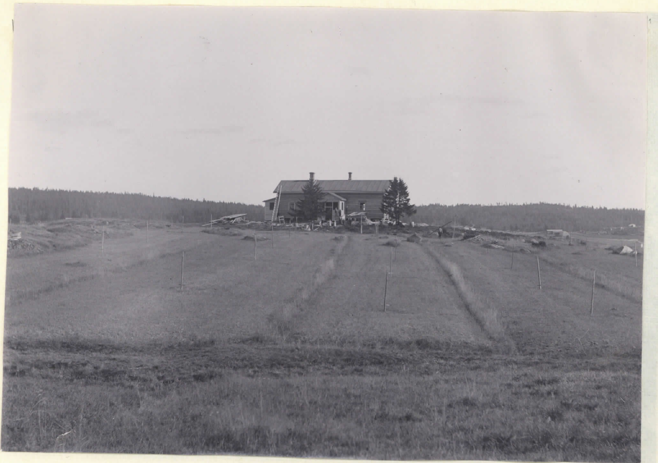
11. Sägösvältaren J. Huskis nybyggnad invid Karkku station, 3020 sedd från järnvägslinjen.
