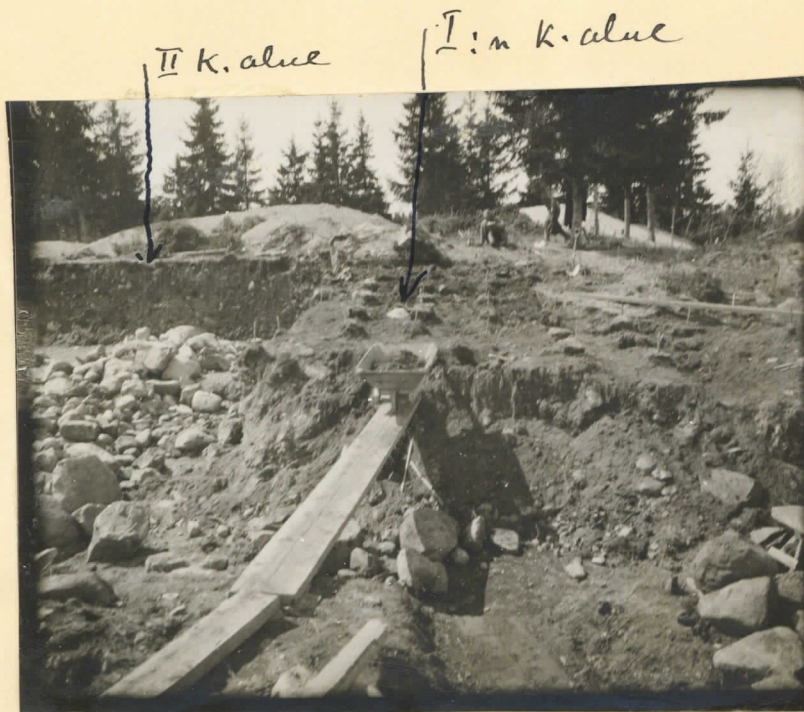
I:n kaivausalueeni, maan- kordun perustan länsinurkkaus. Maantien puolelta
