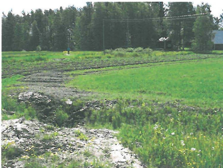
Kuva 7. Kaivettua viemäriinjaa pellolla, Uusipaikan talon luoteispuolella.
